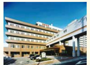
佐野病院新館 完成(平成9年2月)
